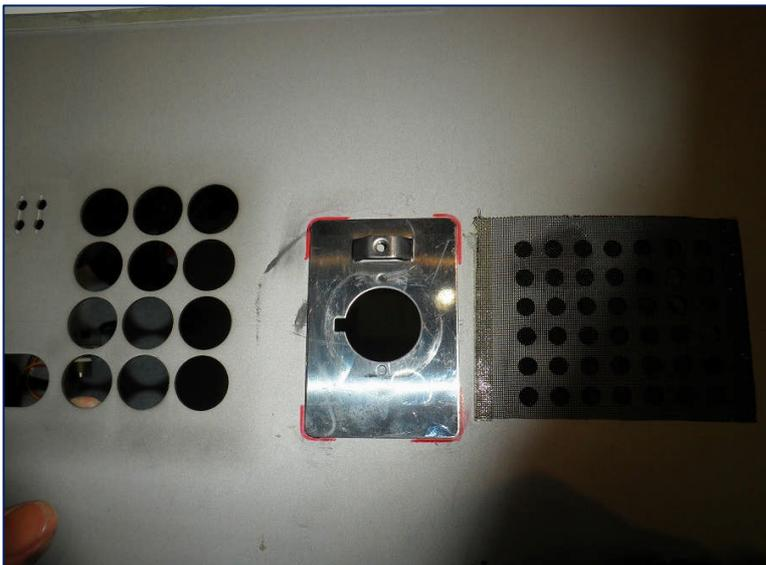
インターホン操作盤の裏にガタ付きが発生しないように裏板取付中(裏面)
