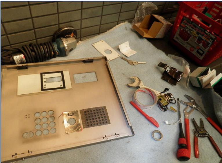
インターホン操作盤のパネルを脱着作業中
