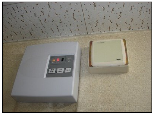
取付け完了後
