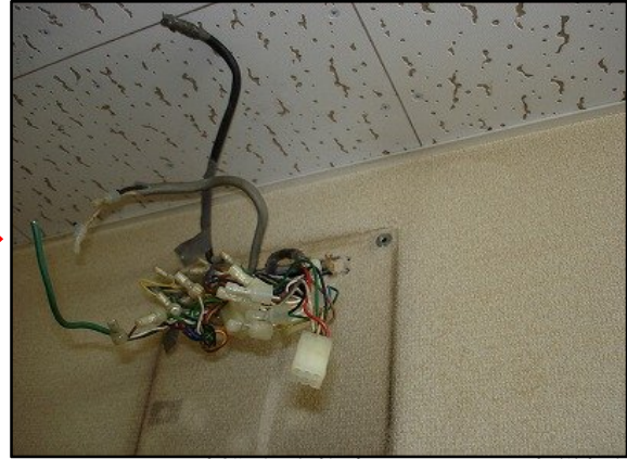
制御盤交換中(インタホン・火災報知器と連動)
