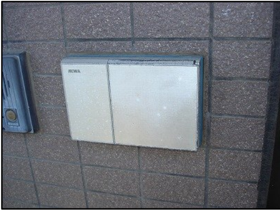
既設のテンキー(子機) 旧型テンキーと新しい制御盤は連動しないため 交換が必要です。
