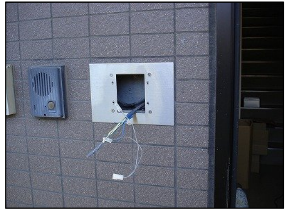
新しいタイプと寸法違いで特注パネルを取付中
