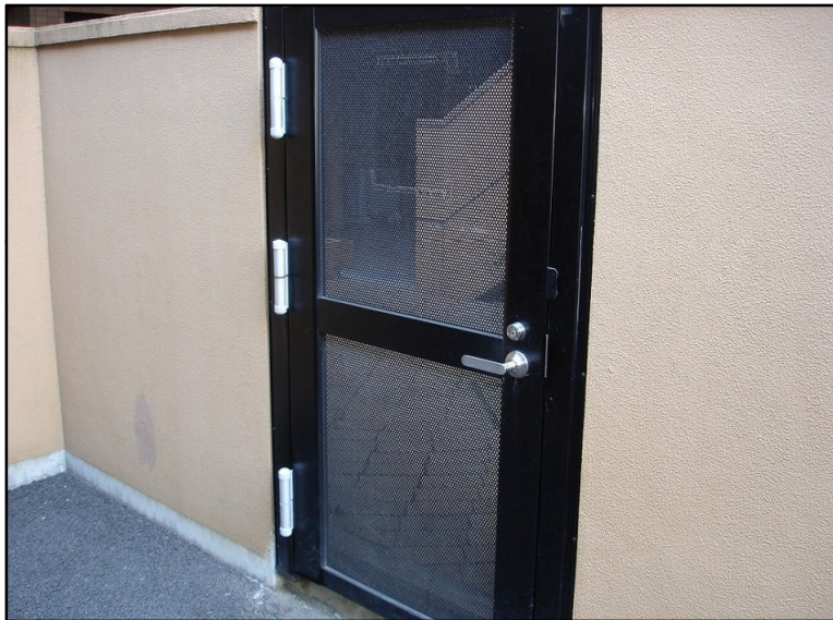
作業終了後(外側から見て)
